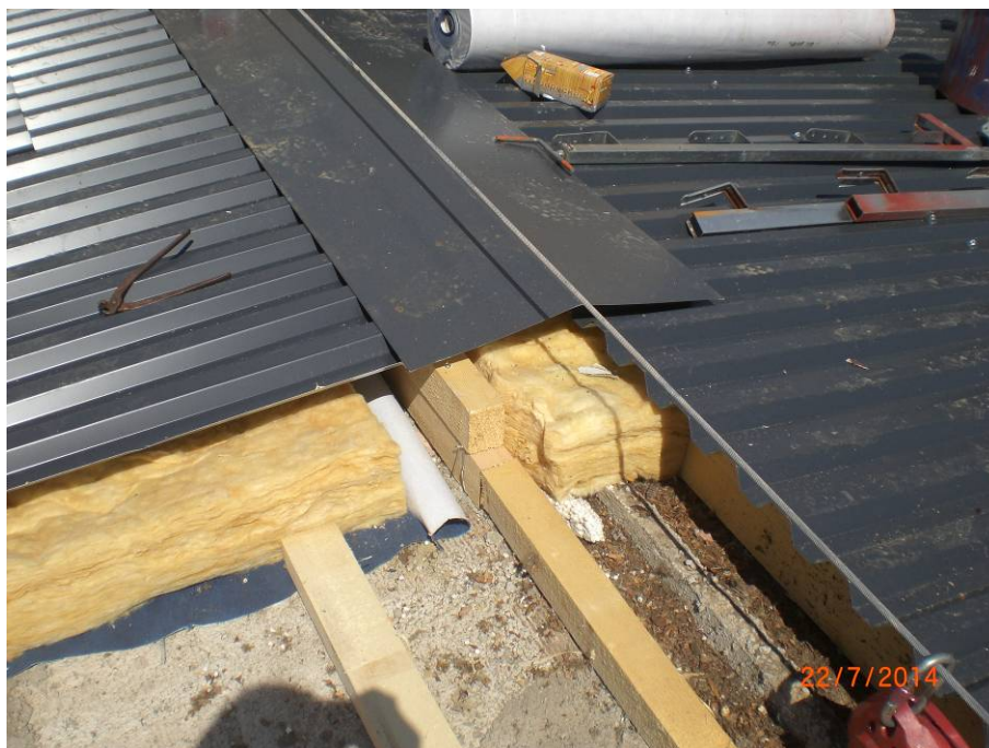
Manto realizzato in lamiera grecata preverniciata con sottostante strato isolante interposto a morali lignei
