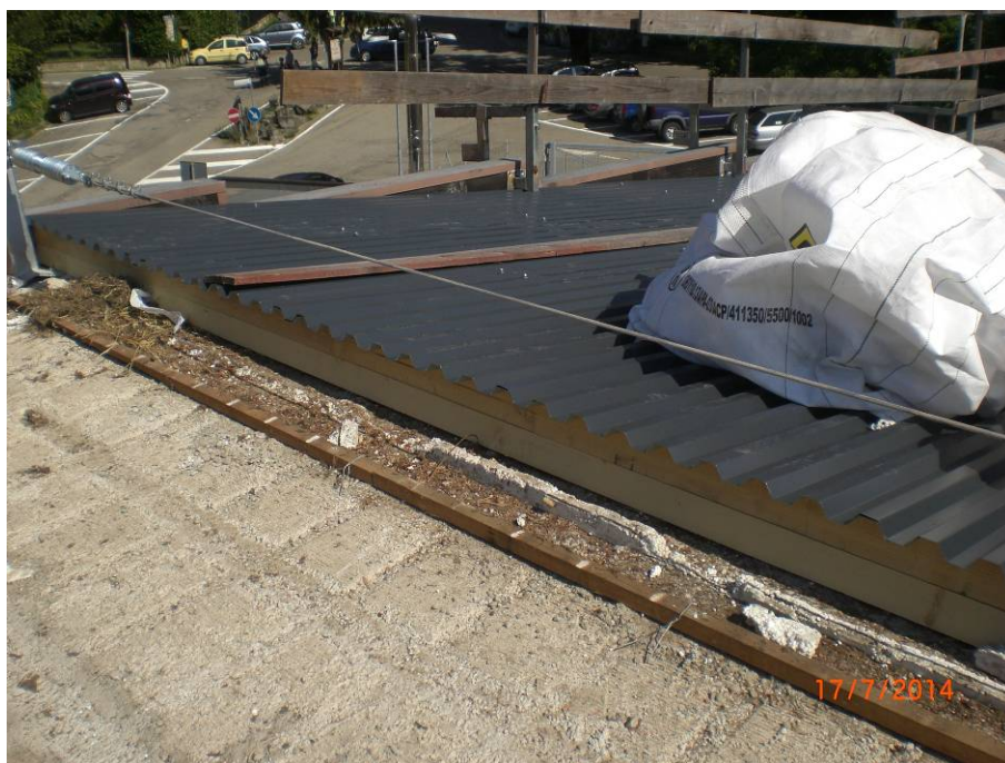
Estradosso del solaio in latero-cemento privo di guaina
