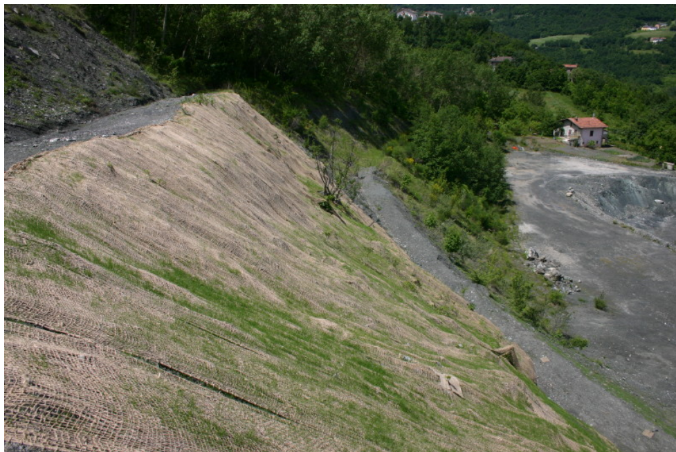
Fotografia 6 - Particolare delle biostuoie
