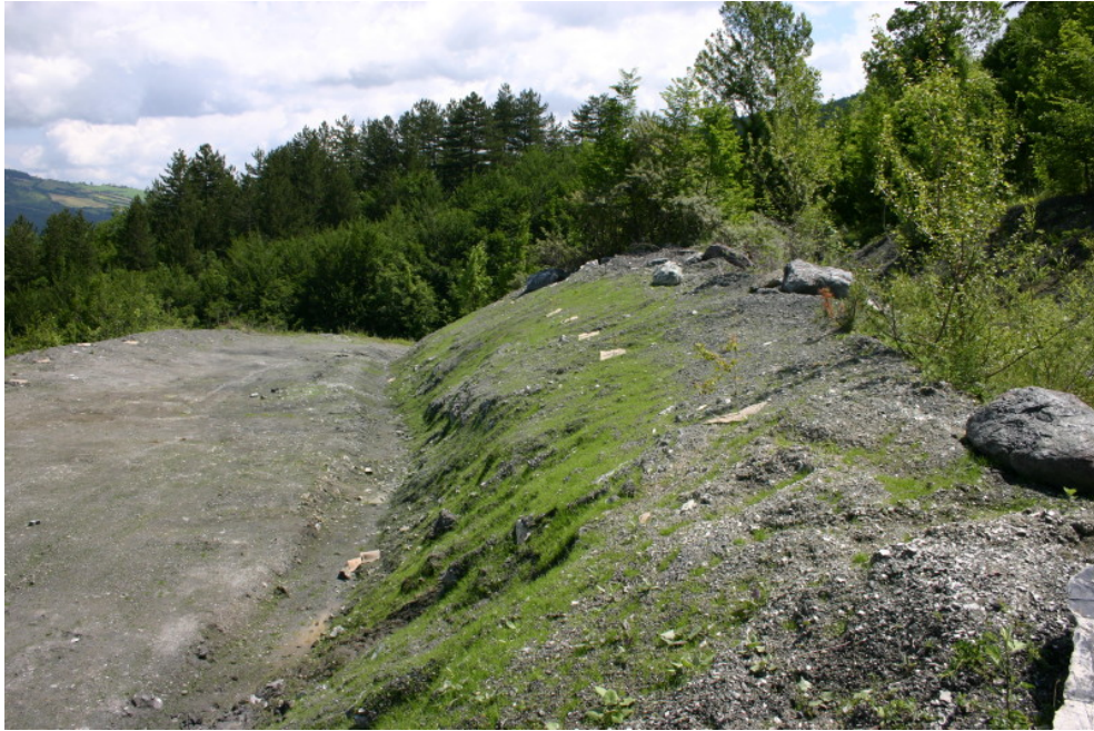
Fotografia 7 - Particolare dell'idrosemina
