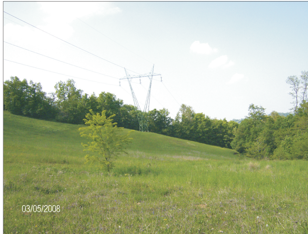
Foto 4 - Panoramica della parte alta della zona di escavazione n. 1. Si noti il traliccio dell'alta tensione, rispetto al quale occorrerà mantenere una distanza di sicurezza di almeno 20 m di raggio.
