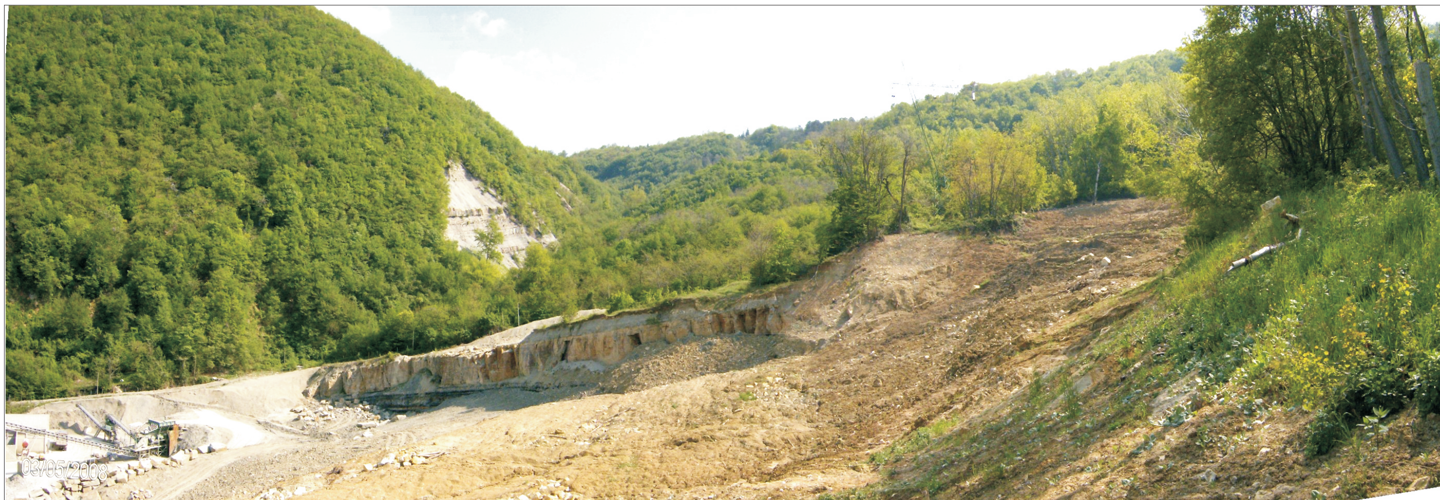
Foto 3 - La frana, vista da nord-ovest; a destra è visibile parte dell'area di coronamento, non ancora risistemata, mentre nella parte centrale è presente la scarpata utilizzata come ultimo fronte di scavo. Tra la vegetazione è possibile osservare il traliccio della zona esterna al perimetro di PAE, e nella parte sinistra il piazzale di cava con il frantoio per la vagliatura del materiale estratto (foto del 03/05/2008)
