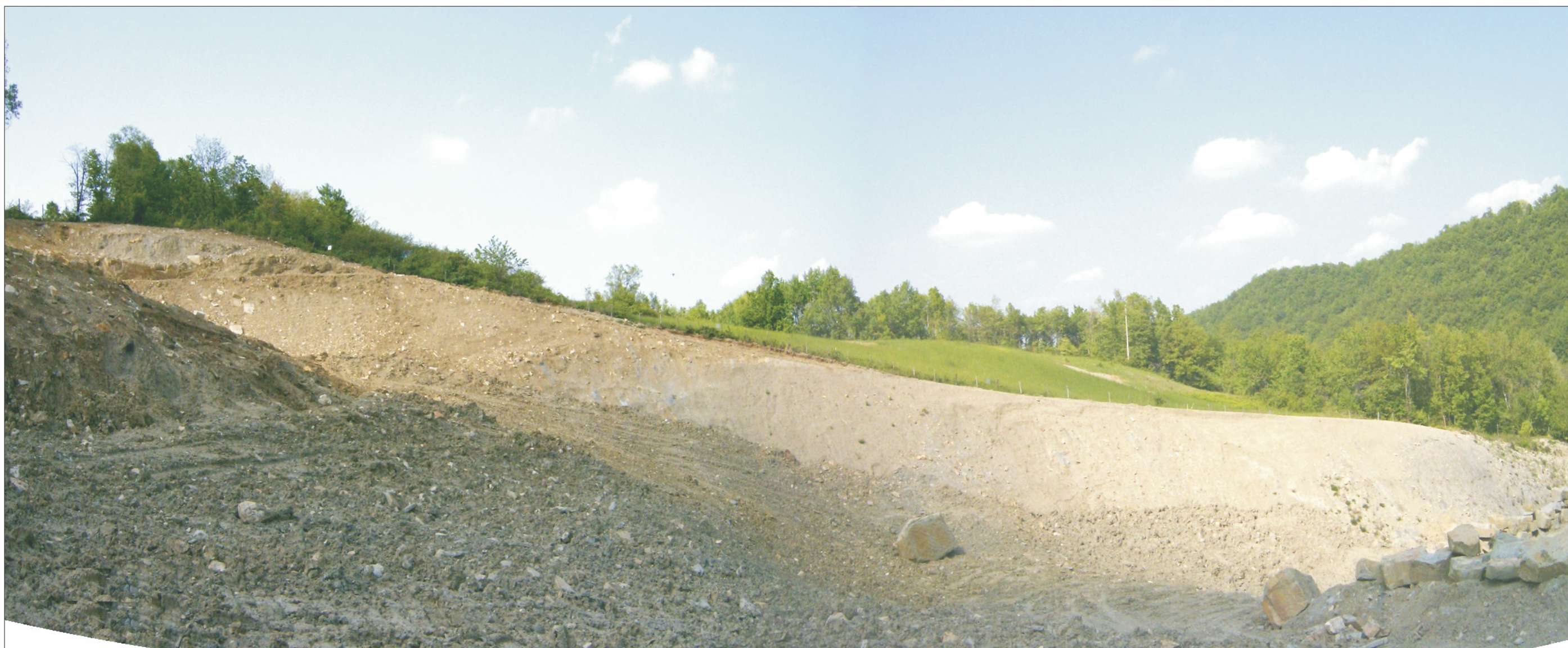
Foto 2 - Panoramica della parte centrale della frana, vista da sud, dove si nota un certo rimodellamento superficiale con la creazione di alcuni gradoni . Sullo sfondo, la scarpata rimodellata che delimita il perimetro di frana dalla zona di espansione del PAE - zona 2 (Foto del 03/05/2008)
