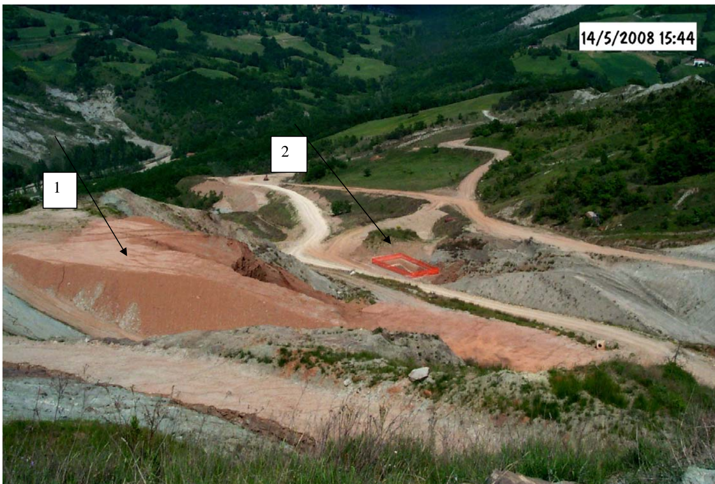
Foto 4 "Cava Morano" 1- materiale estratto 2 – vasca di decantazione
