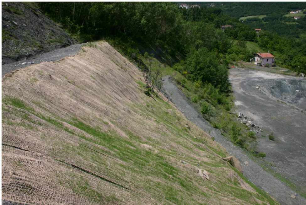
Fotografia 6 - Particolare delle biostuoie
