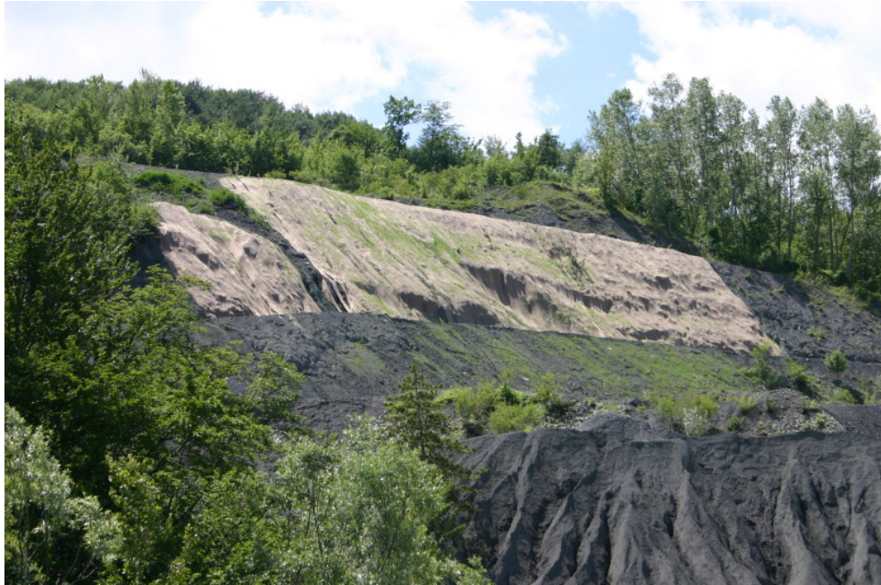
Fotografia 5 - Veduta dei recenti interventi di sistemazione delle scarpate mediante posa di biostuoie ed idrosemina
