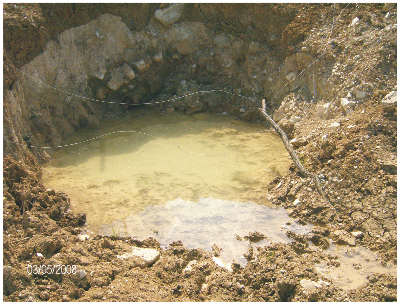
Foto 8 - Scaturigine artificiale di acque sorgive ad est dell'area di frana. Si nota, nella parte in ombra, il cunicolo di afflusso delle acque dalla sorgente.
