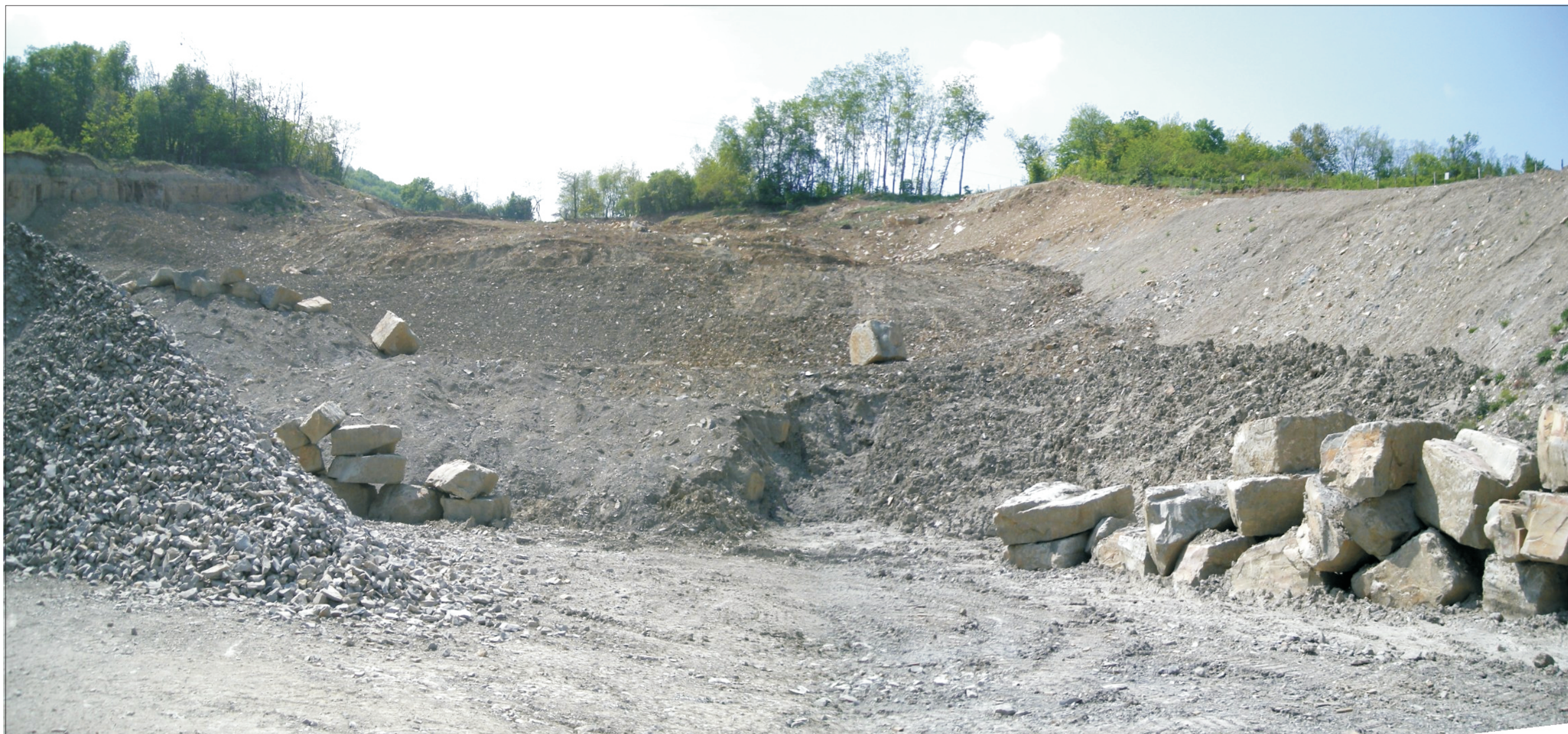
Foto 1 - Piede della frana attivatasi nel 2004, vista dal piazzale di cava; lungo il versante sono stati realizzati alcuni gradoni di rimodellamento del corpo di frana. Si notino sulla destra alcuni blocchi stoccati in attesa di commercializzazione; sulla sinistra è invece presente un piccolo cumulo di inerte frantumato (foto del 03/05/2008)
