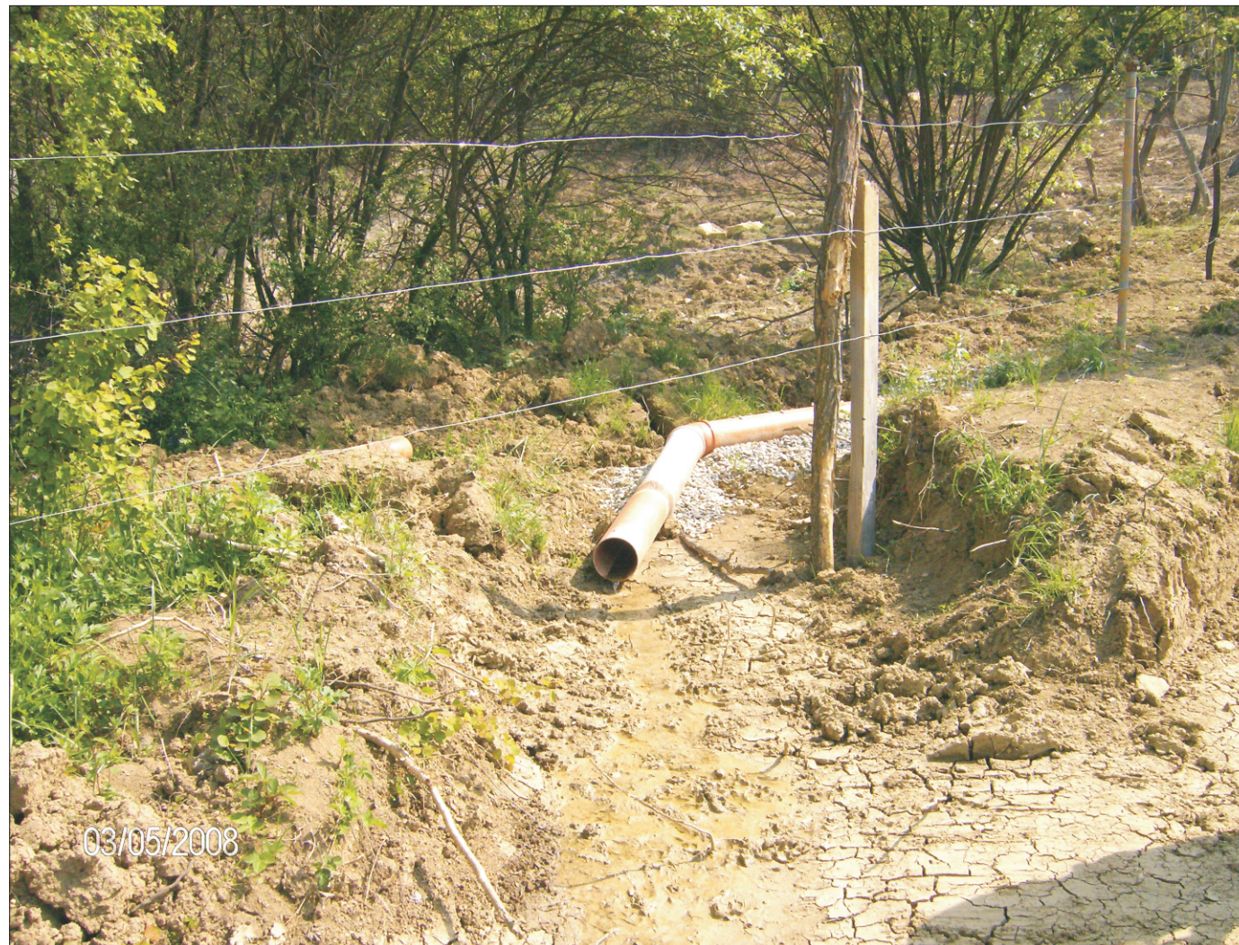
Foto 10 - Il tubo di uscita dal drenaggio posto a monte della frana, che si raccorda con la scolina proveniente dalla scaturigine (foto 8-9).
