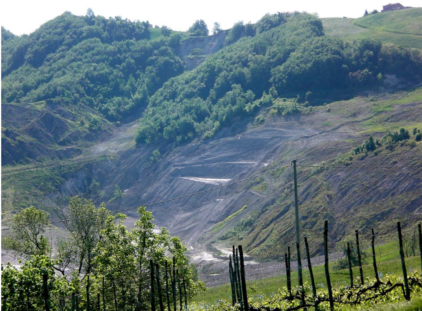
Foto 4 “La Pianazza” vista da via Vandelli Fronte di cava con frana in testata di fossa e su lato sud-est con interruzione del gradone
