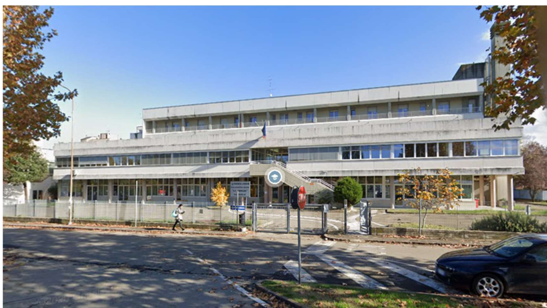
Img. 4.4.1.2.38 - La sede attuale del Liceo A. F. Formiggini di Via Bologna 1 a Sassuolo
