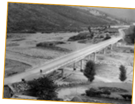
Ponte sul torrente Scoltenna sulla Sp4 Fondovalle Panaro: fine lavori
