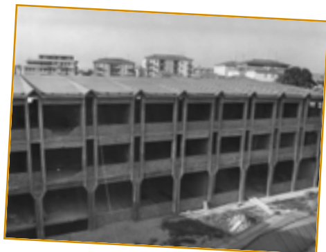
1957, via libera alla realizzazione dell'Istituto Fermi: lato sud dell'edificio in costruzione
