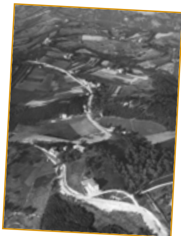
Gaiato di Pavullo, lavori sulla provinciale
