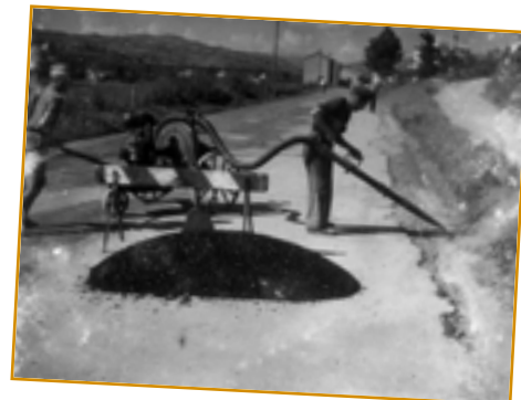
1950, lavori di asfaltatura delle strade provinciali
