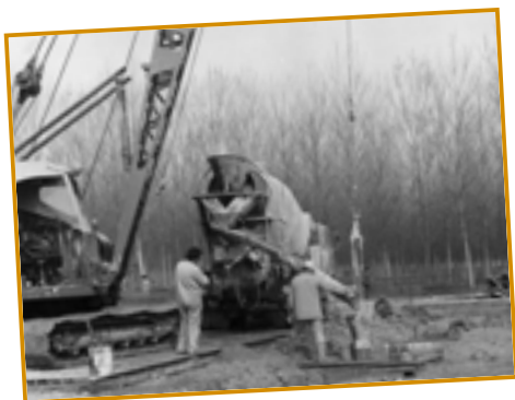
1982, traversa selettiva Casse di espansione nel Panaro
