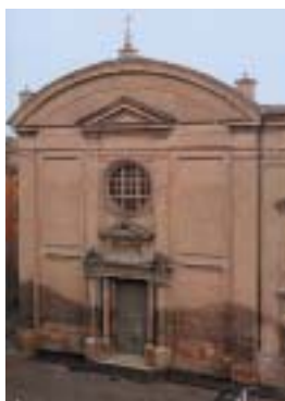
Facciata della chiesa
