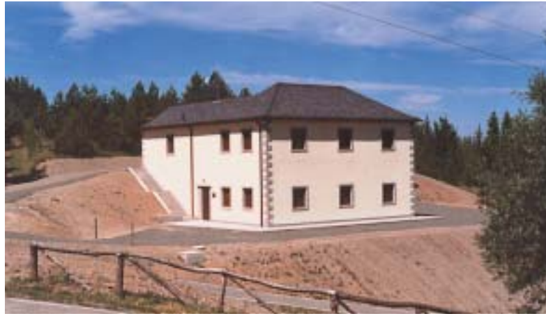
Centro Servizi Parco della Resistenza Monte S. Giulia
