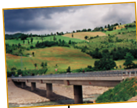
1998, apertura del ponte in località Chiozzo (Montese)
