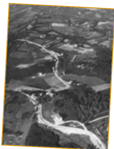
Gaiato di Pavullo, lavori sulla provinciale
