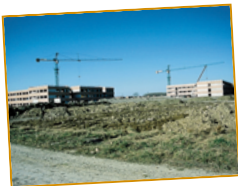
Modena. Lavori di costruzione delle scuole Corni e Wiligelmo
