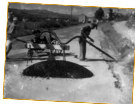
1950, lavori di asfaltatura delle strade provinciali
