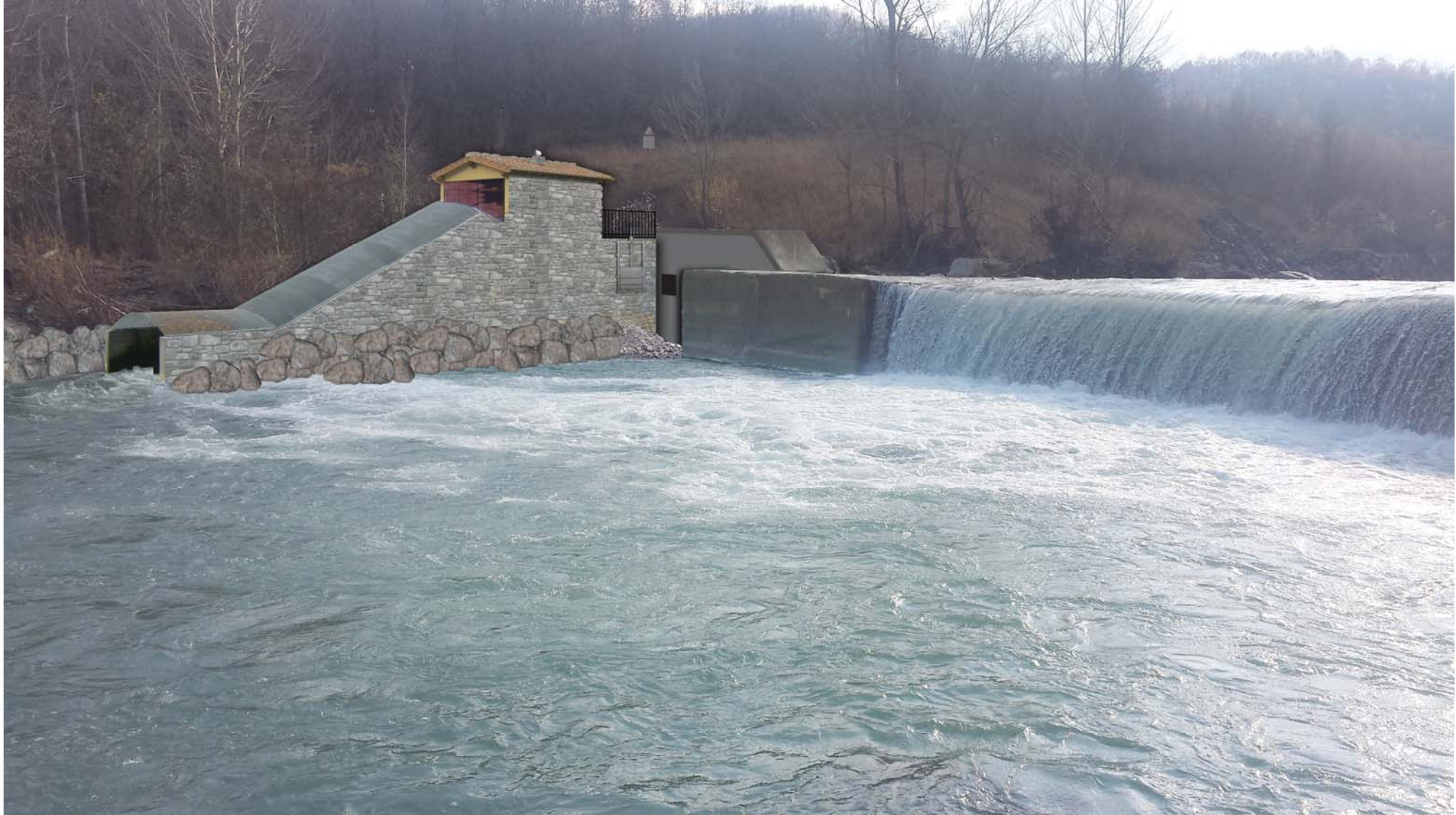
Vista generale dell'intervento ad opera ultimata dalla sponda sinistra del torrente Scoltenna.
