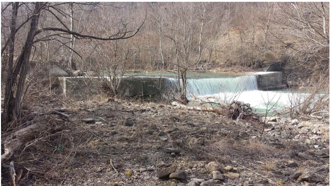
Foto n° 2 Vista da nord-est verso sud-ovest. Vista d'insieme della briglia dal terrazzo fluviale posto a valle della stessa.
