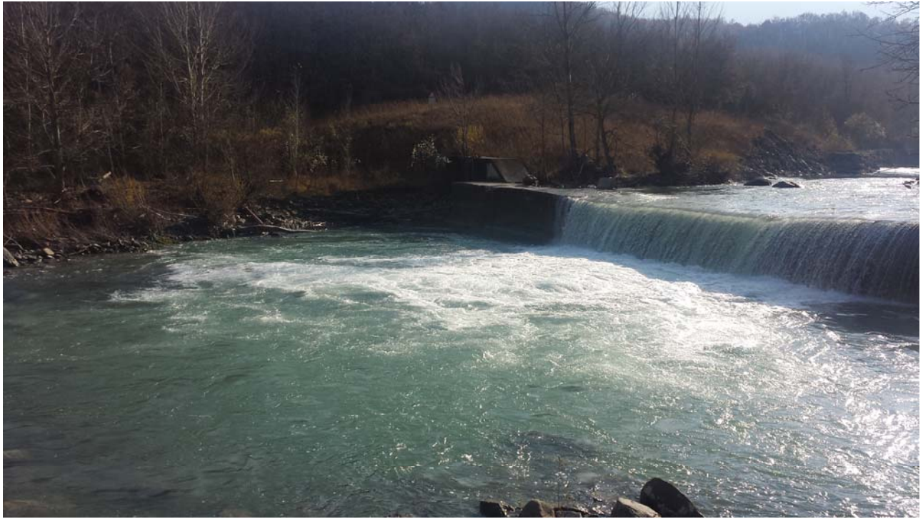
Foto n° 3 Vista da nord-ovst verso sud-est. Vista d'insieme della briglia dalla sponda opposta del T. Scoltenna.
