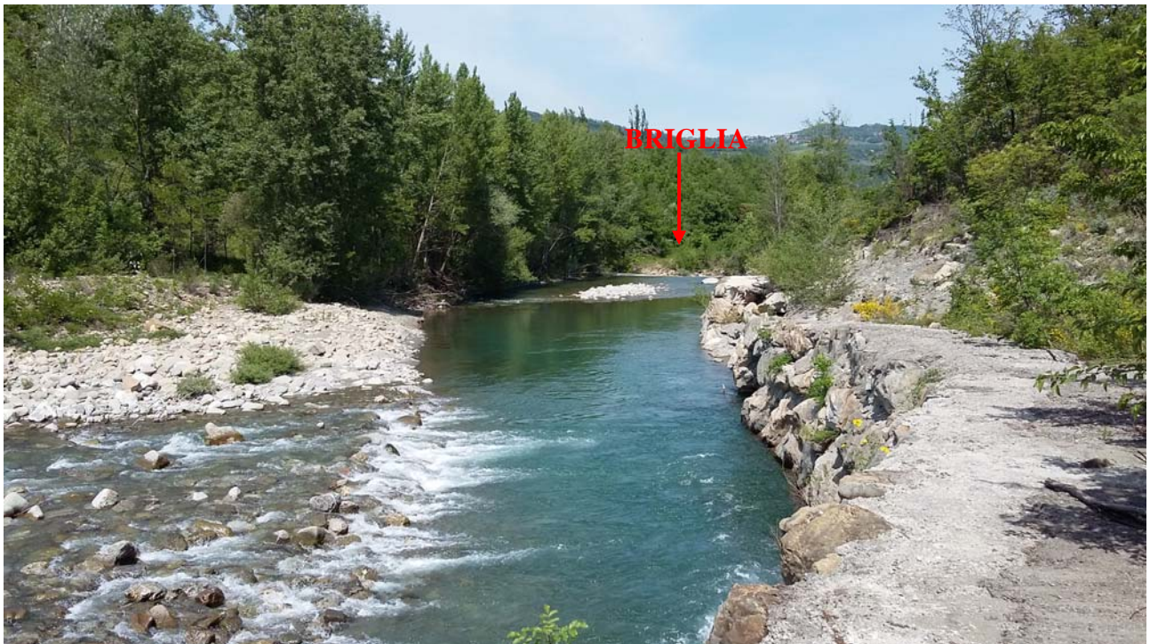
Foto n° 4 Vista sud verso nord. Vista della scogliera esistente a protezione del ciglio d'alveo .
