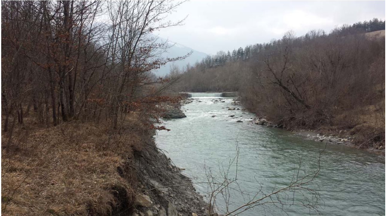
Foto n° 1 Vista da nord verso sud. Sullo sfondo briglia oggetto d'intervento.
