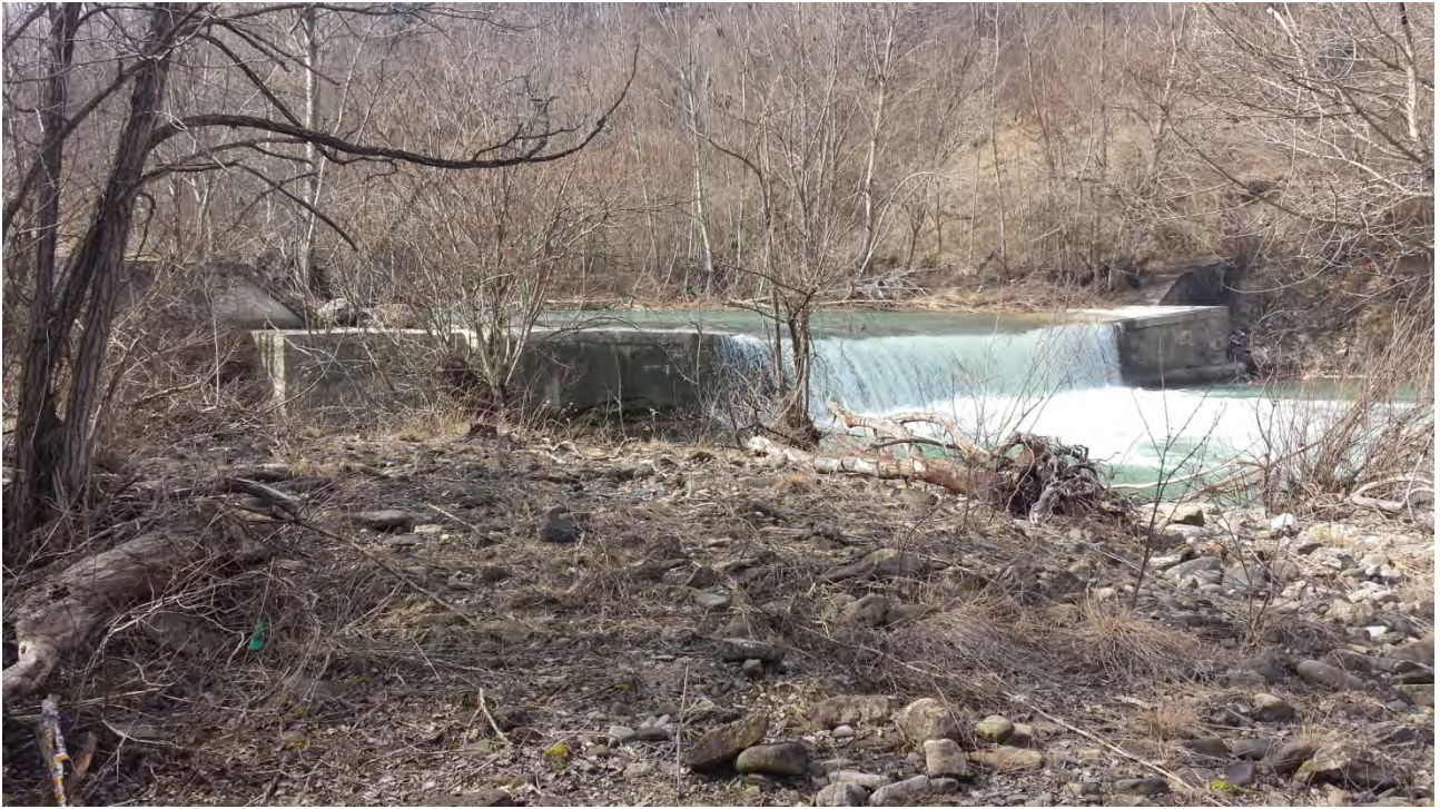
Foto n° 3 Vista da nord verso sud. Particolare del terrazzo fluviale a valle della briglia.
