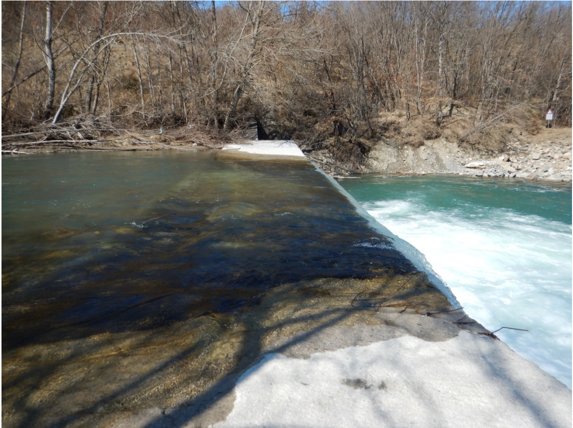
Figura : foto della traversa esistente in stato attuale
