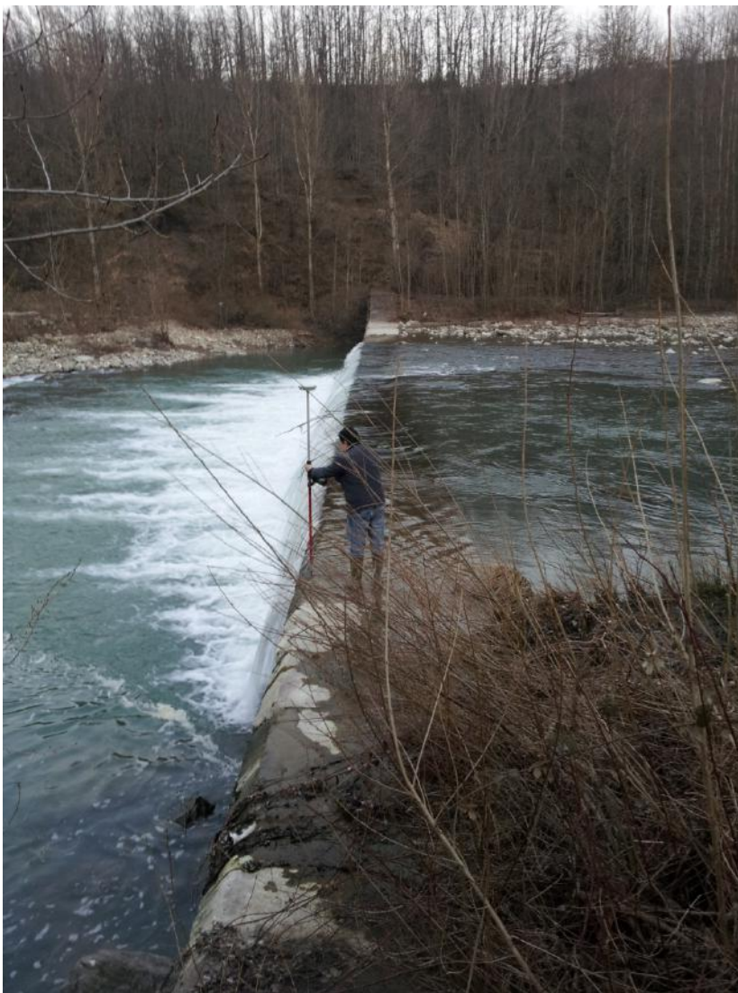
Foto n° 1 Panoramica della sponda destra del T. Scoltenna. Vista d'insieme della briglia da nord-ovest verso sud-est.
