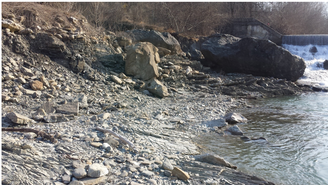
Foto n° 3 Vista d'insieme delle emergenze rocciose a valle della briglia. Vista da nord verso sud.
