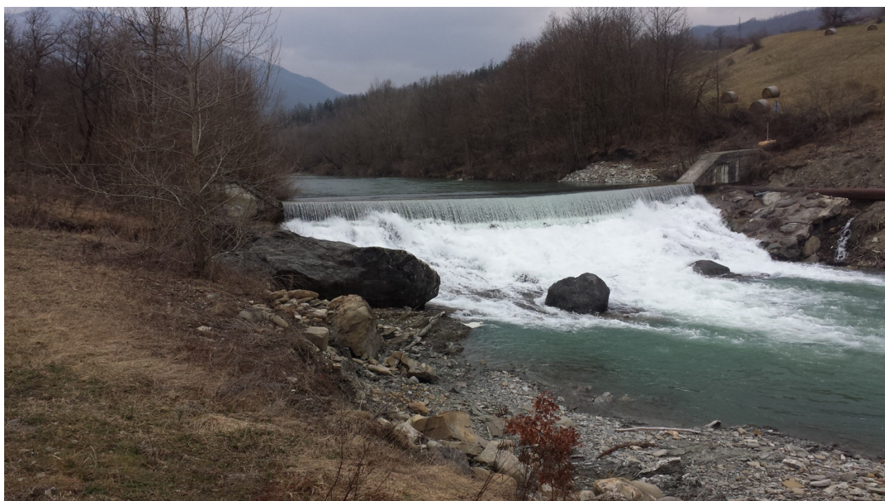
Foto n° 2 Vista d'insieme della briglia da nord verso sud.
