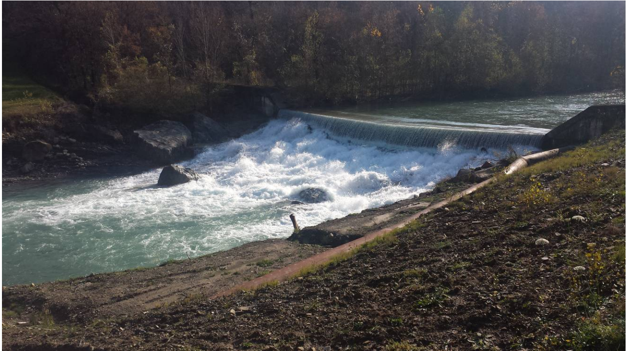
Figura 18: foto della traversa esistente in stato attuale
