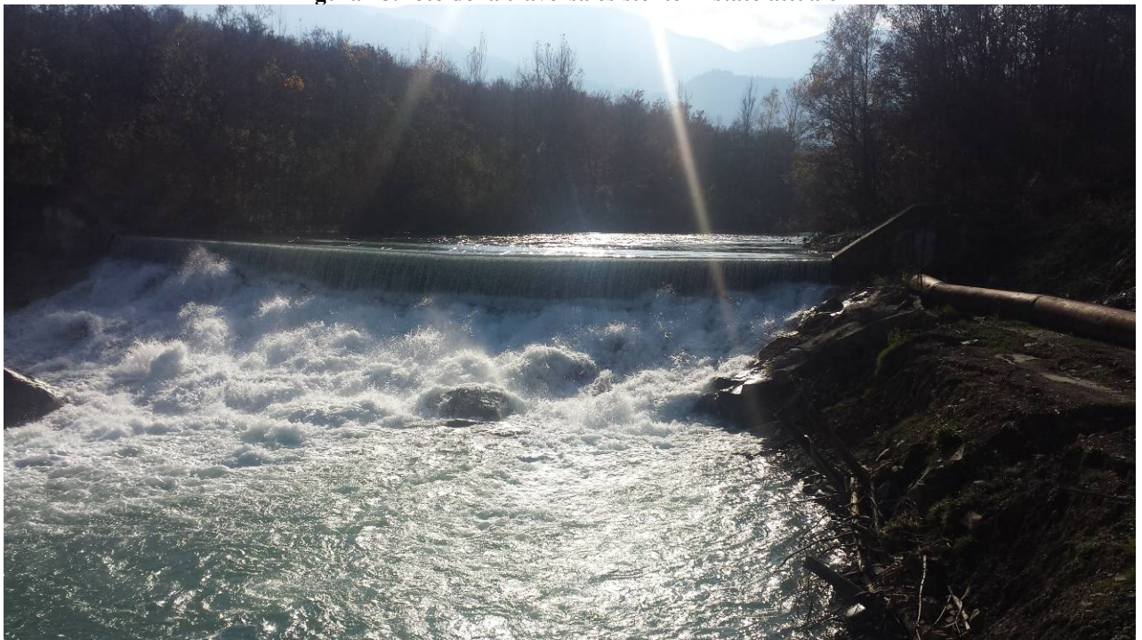
Figura 19:foto della traversa esistente in stato attuale
