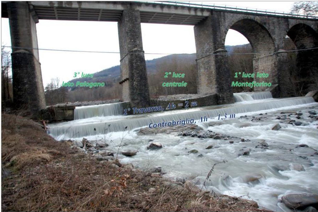
Fig. 2.1 - Ripresa frontale della prima briglia e controbriglia presenti in corrispondenza della SP28. Sono indicate i vari elementi descritti nella presente relazione. Ripresa effettuata dalla sponda destra del Torrente Dragone (Frazione Savoniero, Comune di Palagano).
