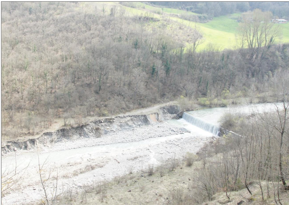
Fig. 2.4 - ripresa laterale dal versante in Comune di Montefiorino della terza briglia. È ben visibile la zona sottoposta a forte erosione immediatamente a valle della briglia in sponda destra.
