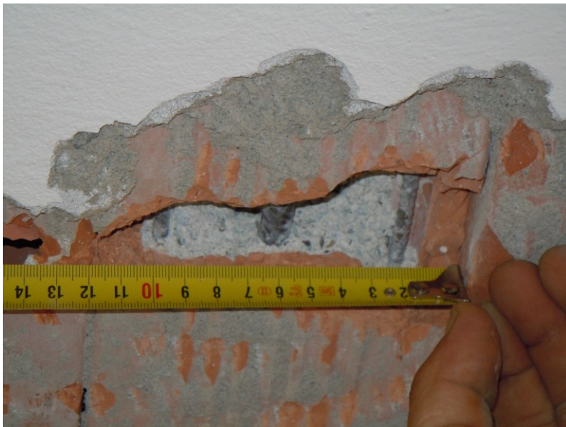
Solaio di copertura
