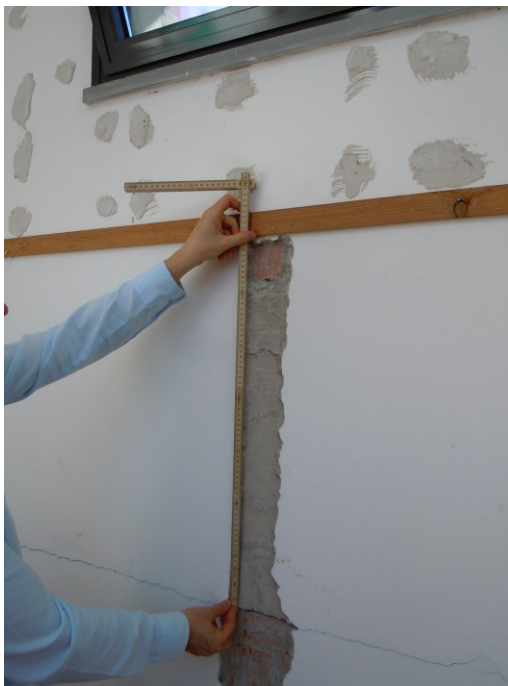
Sondaggio del cordolo (1° livello copertura)
