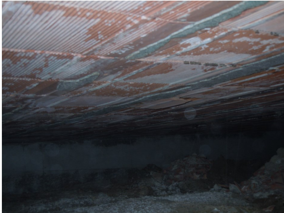
Solaio piano terra (Vista intradosso)
