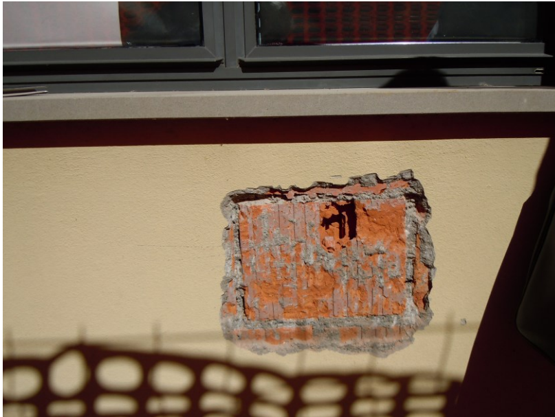
Sondaggio sulla muratura perimetrale esterna
