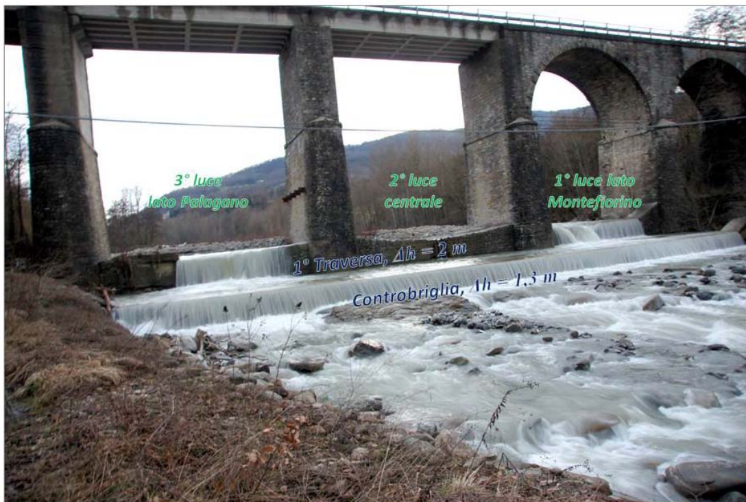
Fig. 1. Ripresa frontale della prima briglia e controbriglia presenti in corrispondenza della SP28. Sono indicate i vari elementi descritti nella presente relazione. Ripresa effettuata dalla sponda destra del Torrente Dragone (Frazione Savoniero, Comune di Palagano).
