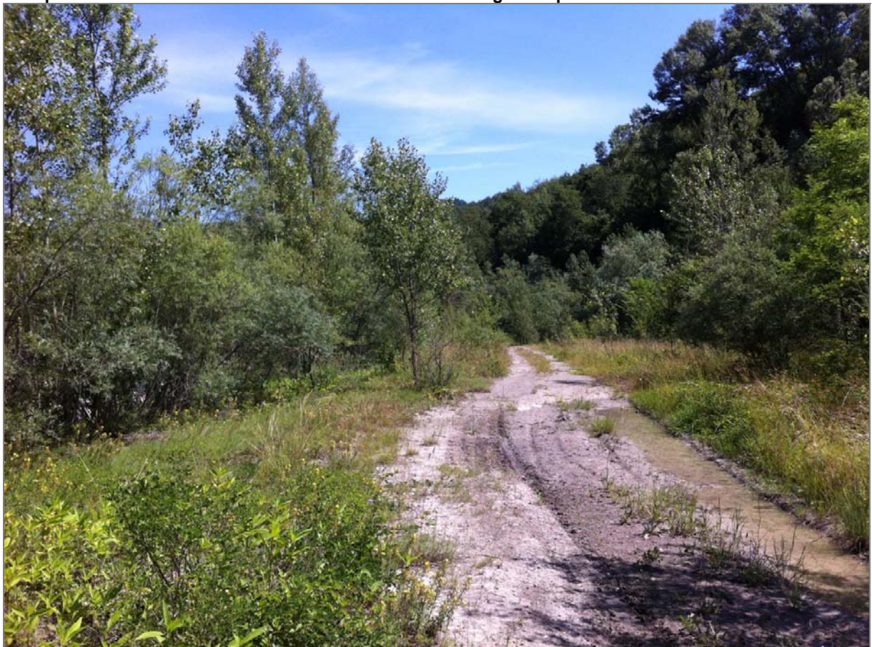
Fig. 4. ripresa laterale dal versante in Comune di Montefiorino della terza briglia. È ben visibile la zona sottoposta a forte erosione immediatamente a valle della briglia in sponda destra.
