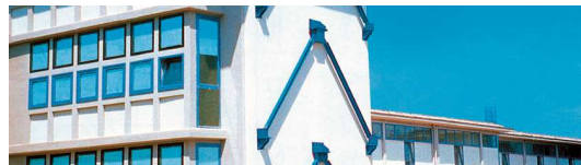
Scuola media Gentile-Fermi di Fabriano
