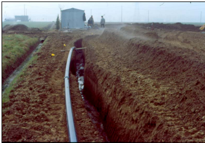
La posa delle tubazioni
