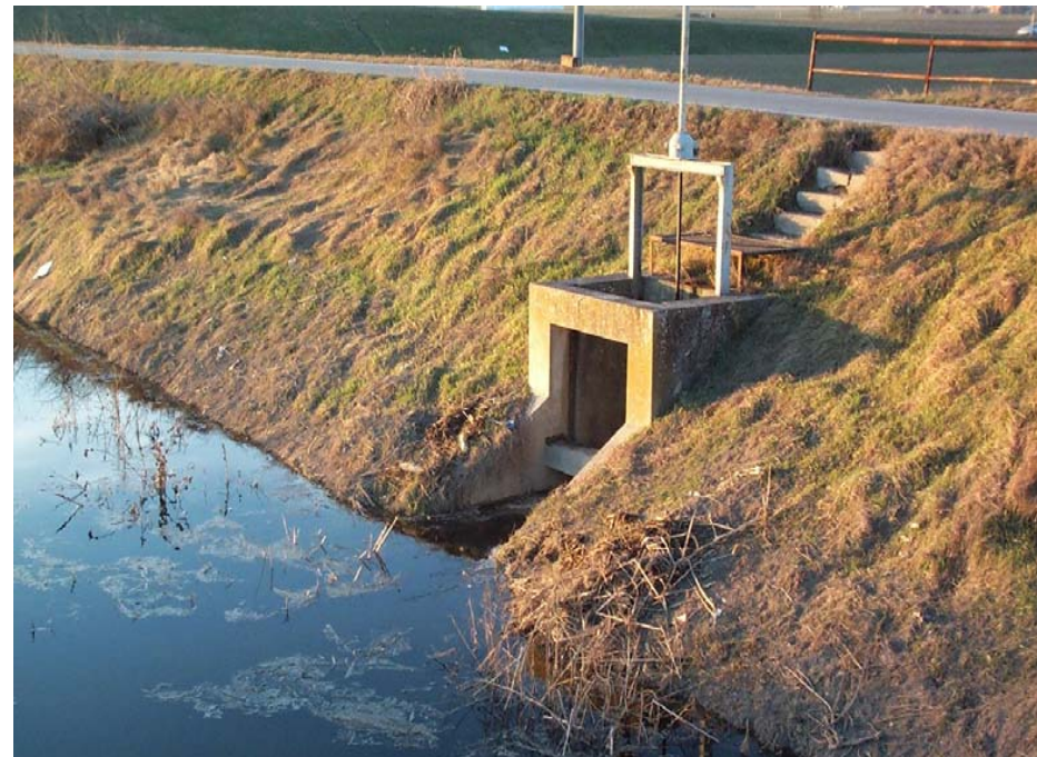
Opera di Presa sul Canale Naviglio Loc. Bomporto
