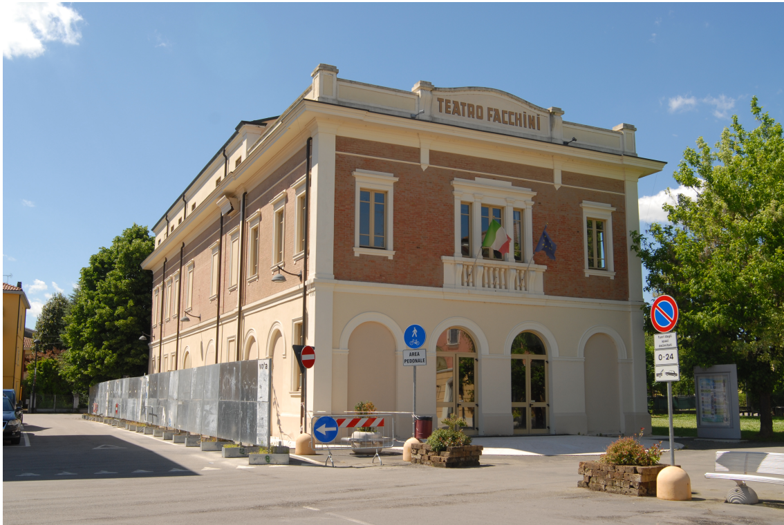
Vista del Prospetto Est
