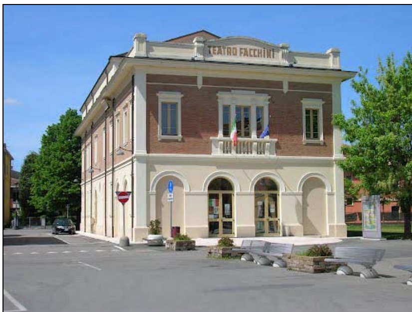
Fig. 1.1: Ripresa fotografica del fabbricato di interesse.
