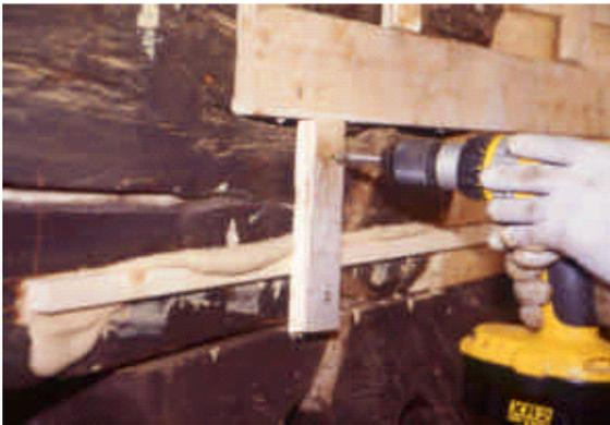
In alternativa ai morsetti si utilizzano traversini di legno avvitati, forzando il listello traversini di legno avvitati, forzando il listello nel canale si ha la fuoriuscita della malta epossidica in eccesso.
