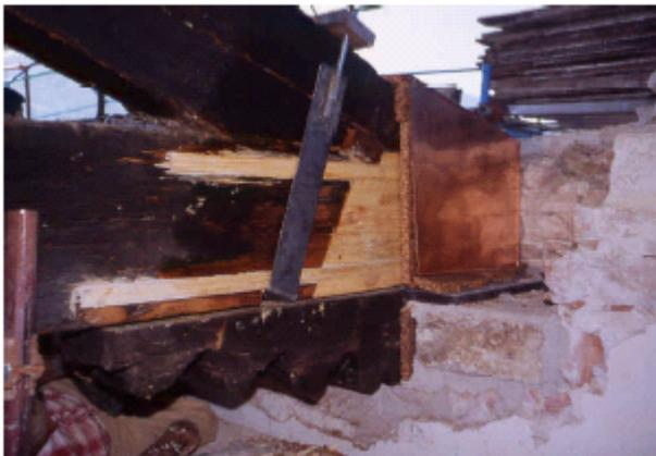
Ad intervento eseguito, messa in opera della fascia metallica passiva. Prima della ricostruzione della muratura la testata viene trattata con prodotto preservante insetticida e fungicida, rivestita con foglio di sughero da 3cm e protetta con una cuffia di rame.
