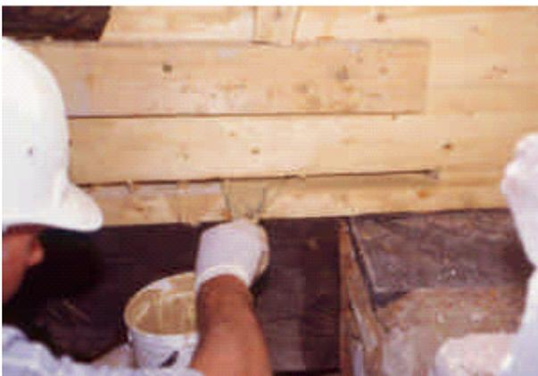
Spalmatura della malta epossidica con uso di una spatola larga, è bene utilizzare anche un'altra spatola di larghezza non superiore a quella del canale. Le tavole fissate lungo i lati assicurano l'assenza di movimenti fino a incollaggio efficace.
